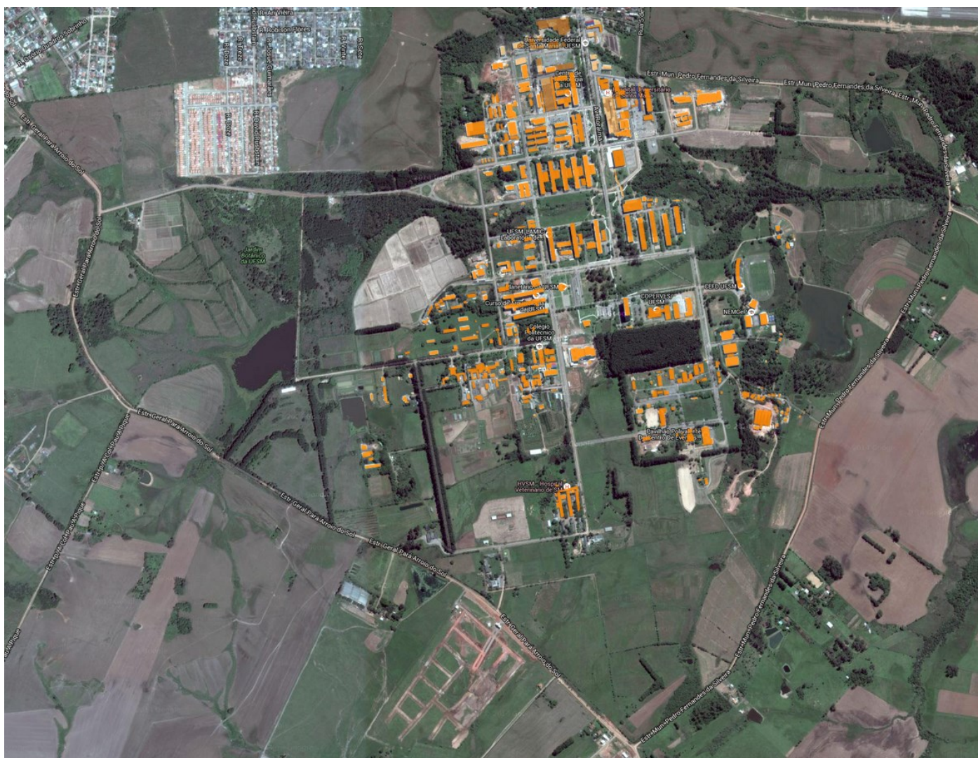
Figura 46 - Vista Superior da UFSM com telhados mapeados
